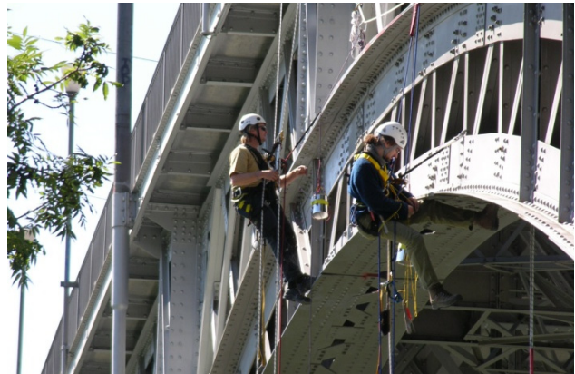
1 Arbeiten am Seil erfolgen immer mit Arbeits- und Sicherungsseil.
