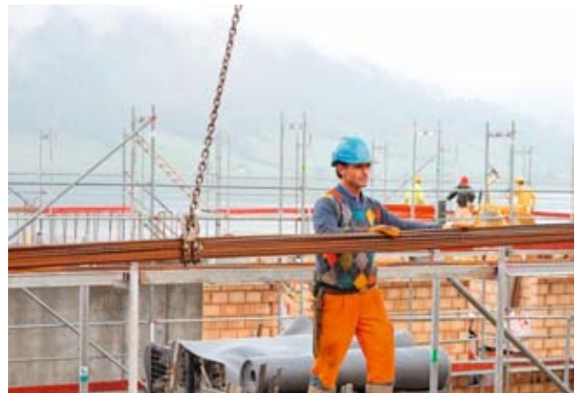
4 Krantransport eines Bewehrungsseisenbundes
