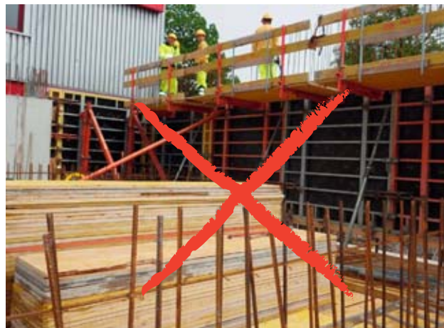
1 Ungesicherte Anschlussbewehrungseisen
