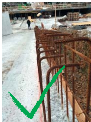
2 Anschlussbewehrungseisen mit Winkeln ausgebildet
