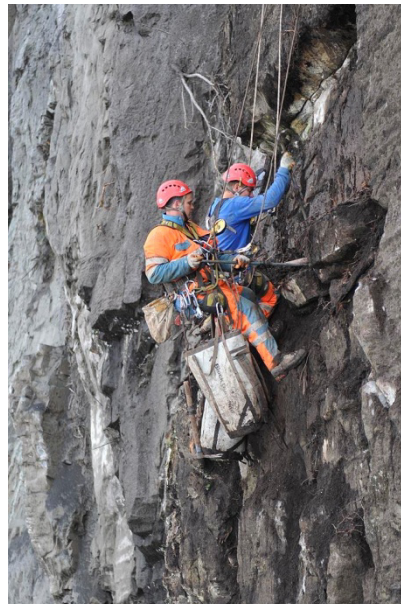
1 Felssicherungsarbeiten stellen höchste Anforderungen an die Arbeitsvorbereitung und Ausbildung der Mitarbeitenden.
