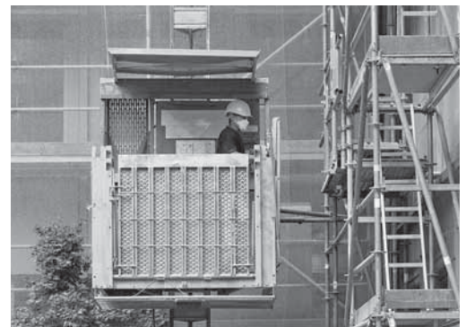
Bild 3: Plattform mit Schutzdach
