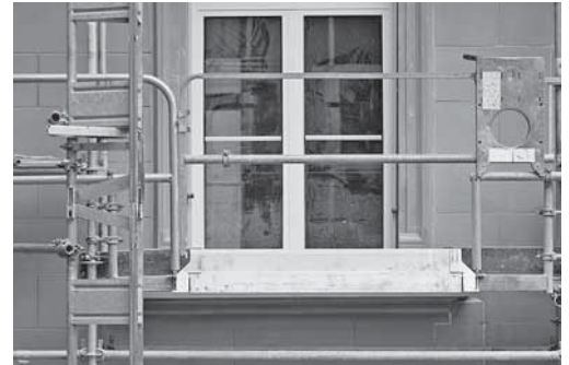
Bild 1: Verladestelle mit Türverriegelung
