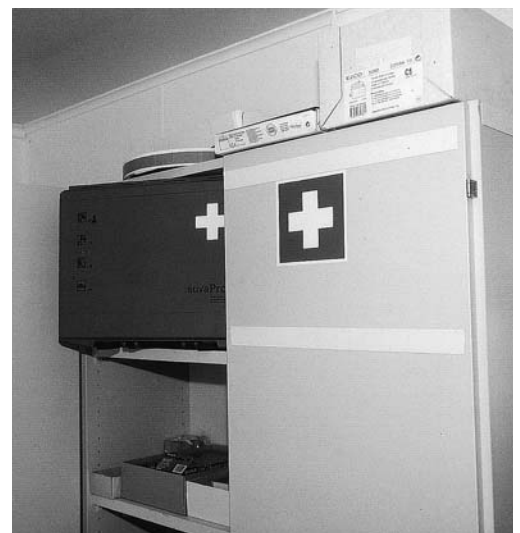
Bild 2: Die Standorte der Apotheken müssen gut sichtbar gekennzeichnet sein.
