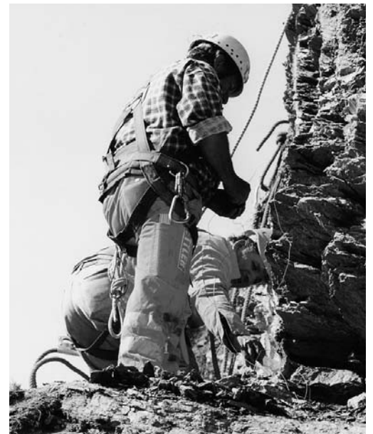
Bild 3: Mit Auffanggurten und Seilen gegen Absturz gesichert.
